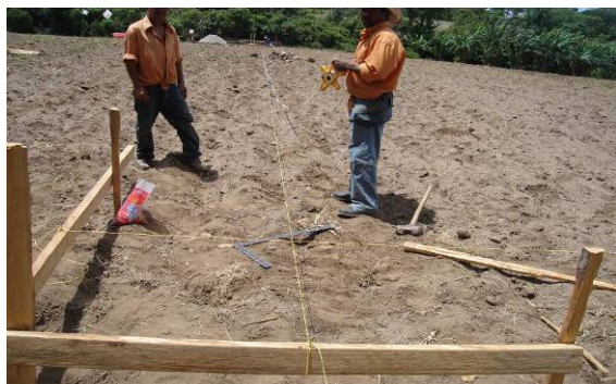
Trazado del terreno para el invernadero
