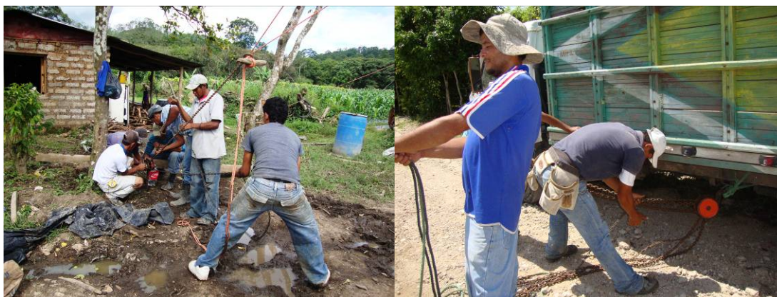
El tecele se fija a un tronco (Izquierda) o a un camión (Derecha).
