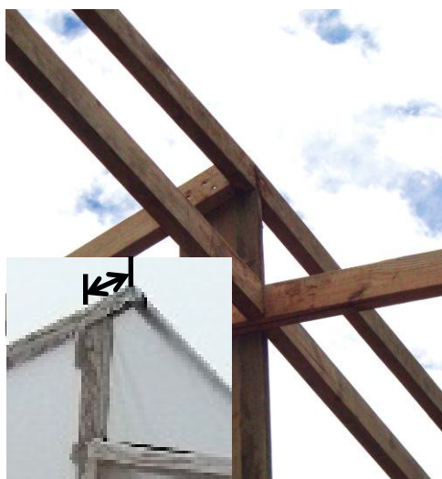
En el poste central podemos ver ya todas las vigas de 2 X 4 en su lugar formado el techo y la venta cenital. Ventana con 30 cm de alero
