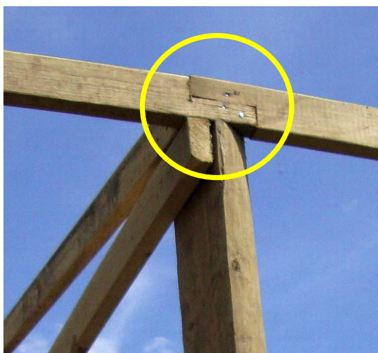
El enchape de las piezas de 2 X 4 se deben de realizar sobre los postes para no perder la resistencia de las vigas
