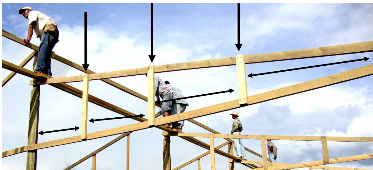
La piezas de refuerzo para la tijera se dejan equidistantes de 1.38 m de ambos extremos y de cada una del lado bajo y del lado alto es de 1.30 m.
