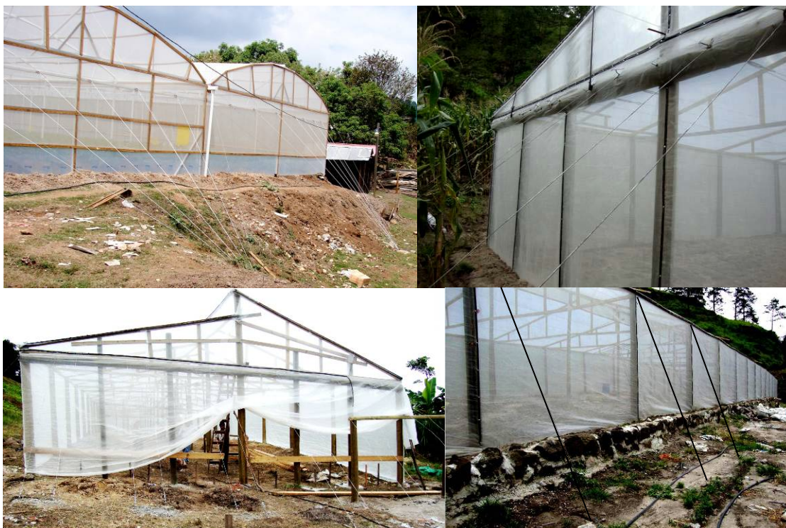
Anclaje de tensores usando bases de cemento de un metro de profundidad
