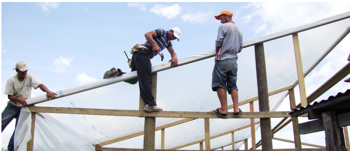
Fijado del plástico del extremo opuesto del tecele
