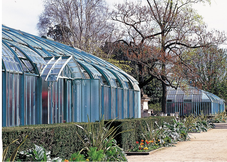
La ventilación del invernadero se garantiza sobre todo mediante ventanas móviles. (© E. Gueyne, Alpha-Omega)
